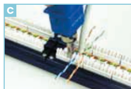
C Termina los cables.
